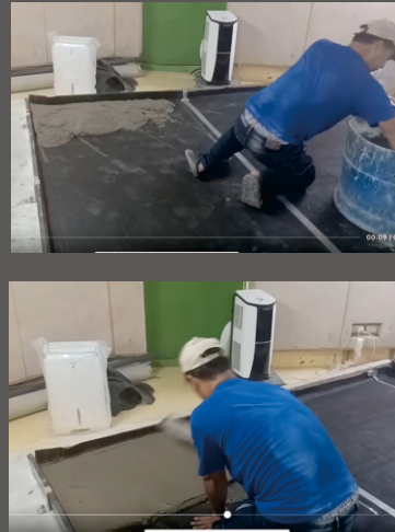
再用1:3水泥砂漿塗抹水平,完成厚度為:5CM
