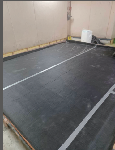
dB橡膠墊黑色不織布朝上鋪貼，靠齊後用膠帶貼合
